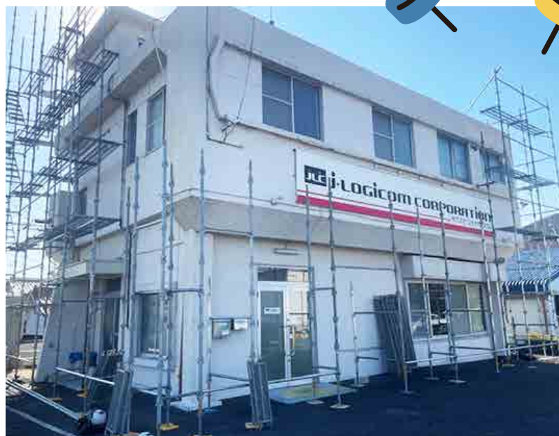
外装工事風景 思ったよりも汚れていました
